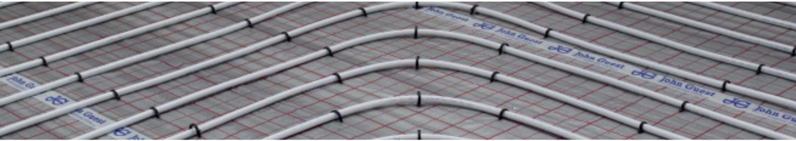
Mehr als 50% aller in Deutschland eingebauten Fußbodenheizungssysteme werden als Tackersysteme ausgeführt. Sie ermöglichen variable Verlegeabstände und lassen sich ideal an die verschiedensten Raumgeometrien anpassen. Wie die anderen JG Systeme ist auch das JG Tackersystem für die Installation von Flächenheiz- und -kühlsystemen geeignet.
